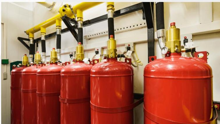
O sistema de supressão Kidde é um sistema de supressão de incêndio de pó seco pré-projetado que oferece detecção e supressão automática completa de incêndio. A detecção é realizada através de cabo linear e atuação do sistema são realizadas para descarregar o conteúdo através de uma rede de mangueiras de descarga e tubulações.
